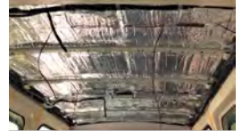
制振・断熱施工
