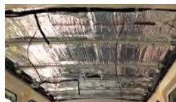
制振・断熱施工
